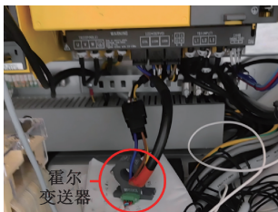
图2 霍尔交流电流变送器安装示意图
