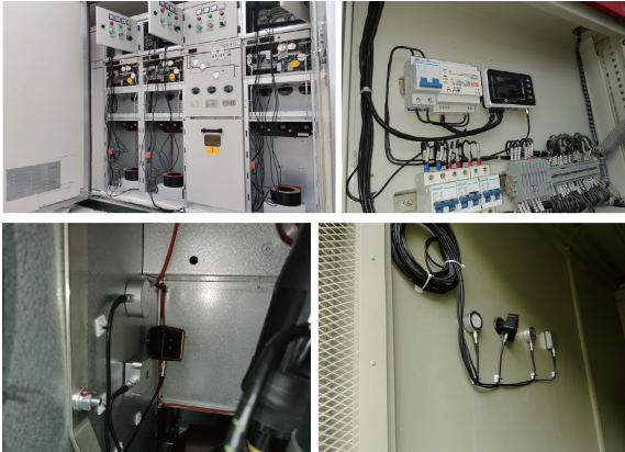
图 16 变压器箱变传感器部署
