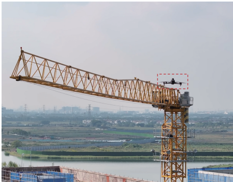
图 6 无人机正在巡检塔式起重机 Fig. 6 Drones inspecting tower cranes
