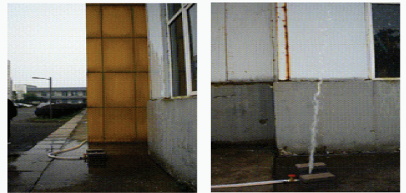
图 7 实验现场 Fig. 7 Blowout simulation test site
