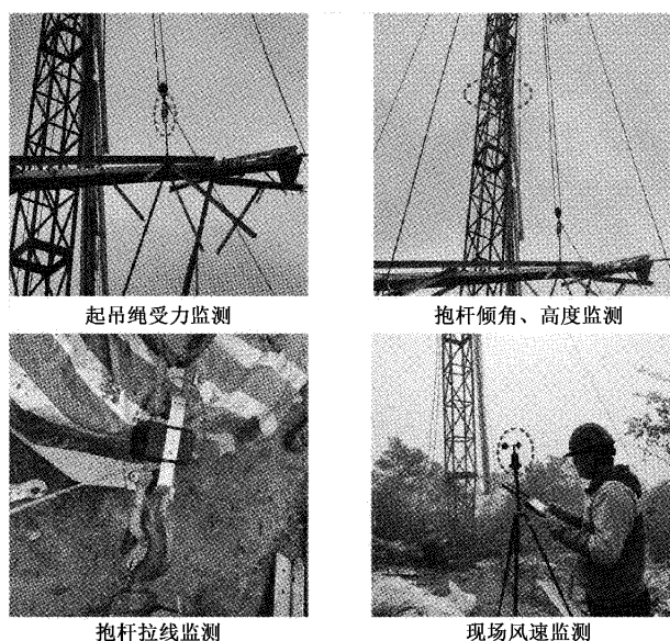
图8 内悬浮抱杆输电铁塔组立监测系统现场应用
